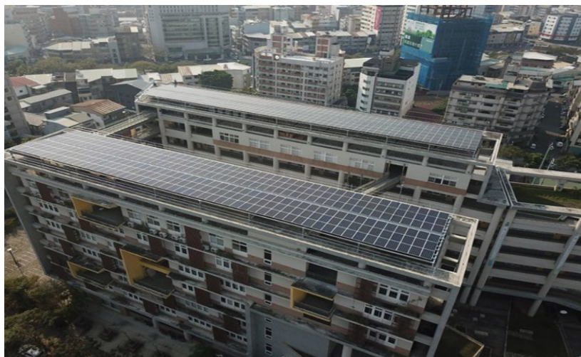
圖 4.8.1.1 本校建築物屋頂裝置的太陽能板
